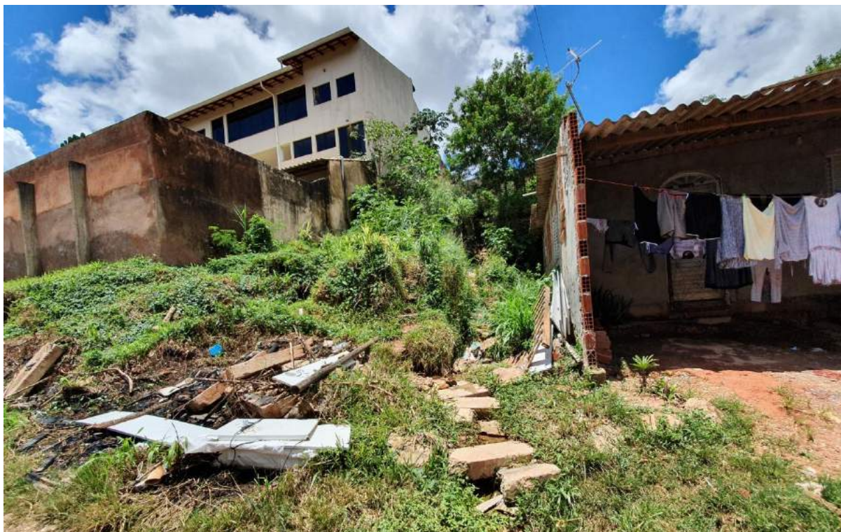
Figura 32 - Ponto 14 Campanha 2. Exemplo de ocupação urbana em área com declividade maior que 30%. Este tipo de ocupação requer a instalação de elevados muros de arrimo para viabilização de edificações.
