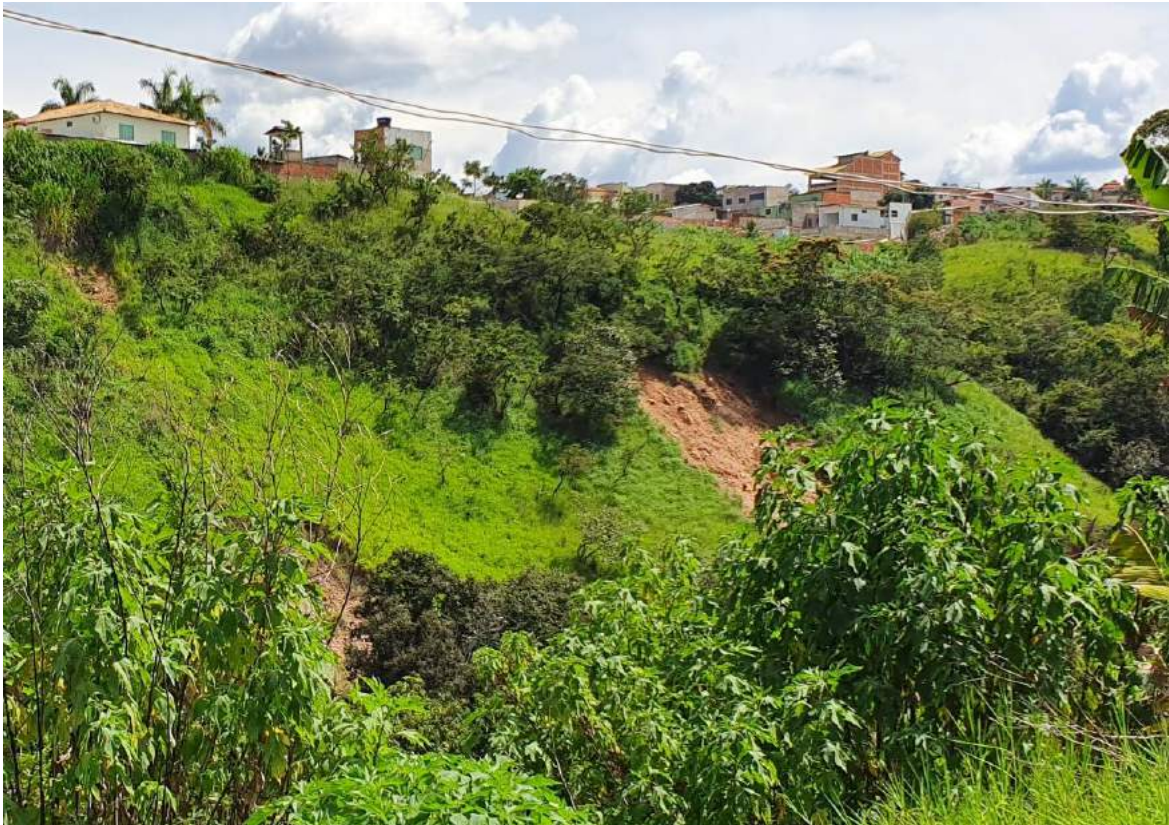
Figura 25 - Exemplo de processo de deslizamento de encosta íngreme devido à infiltração de águas na porção elevada da vertente. Ponto de Erosão 29 Defesa Civil. Fotografia tomada a partir do Ponto 61 da Campanha 1.
