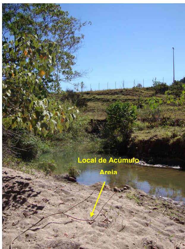
Figura 8 – Material arenoso inconsolidado na porção sul da poligonal do Parque (córrego Guará).
