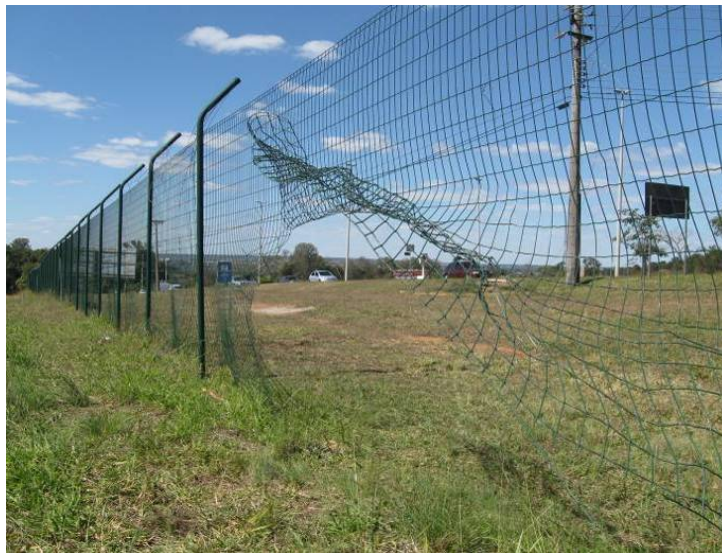
Figura 60 – Alambrado avariado: Julho de 2009.
