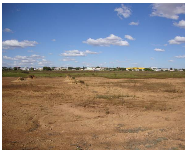
Figura 75 – Visão geral de parte da lagoa de oxidação desativada 1.
