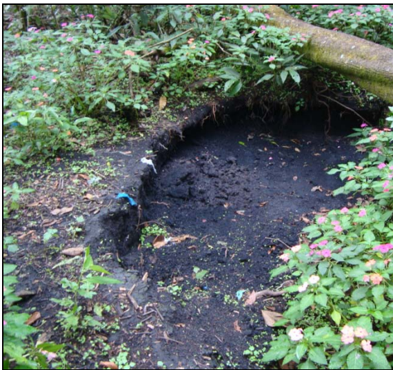
Figura 29- Retirada de terra.
