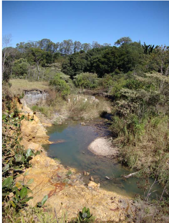
Figura 10 – Solapamento de margem no córrego do Guará e exposição de extrato rochoso.
