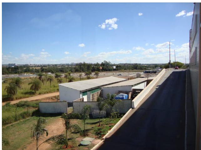
Figura 87 – Utilização da área 28A como estacionamento e área de apoio a obras.
