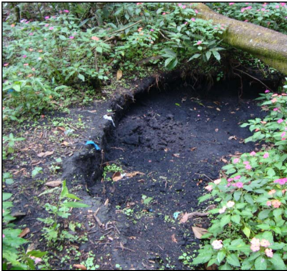
Figura 32 - Retirada de terra.
