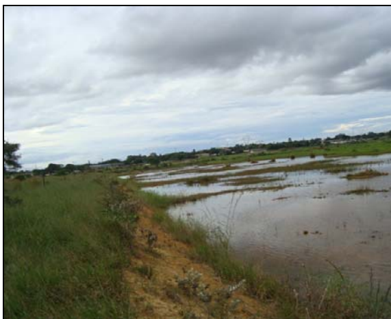
Figura 24 - Lagoa de estabilização desativada.
