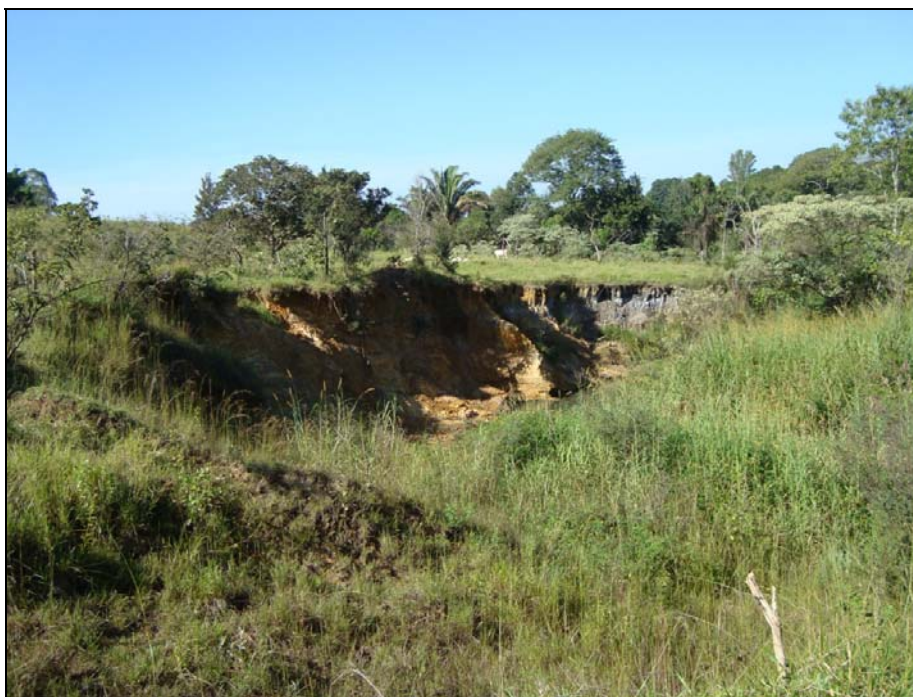
Figura 36 - Processo erosivo acentuado nas margens do córrego Guará.
