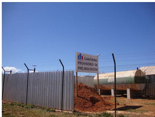
Figura 88 – Área 28A sendo utilizada como canteiro de obras do Park Shopping.
